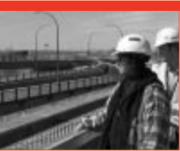
Des travailleurs surveillent les travaux de construction du nouveau pont de la route Transcanadienne Est.
