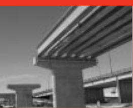
Installation des poutres du nouveau pont de la route Transcanadienne Est.
