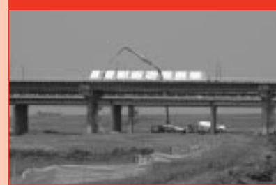
Coulée de ciment pour le tablier de la structure du pont de la RPGC n° 59 Sud
