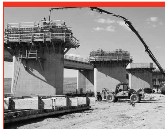
La construction du nouveau pont ferroviaire du CPR à Emerson devrait être terminée à l'automne 2009.
