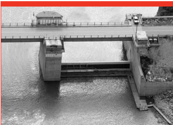
Des travaux d'amélioration sont en cours sur l'ouvrage régulateur d'entrée.
