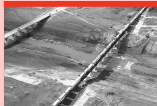
Le nouveau pont ferroviaire CNR à Redditt a été ouvert à la circulation en juin 2008.
