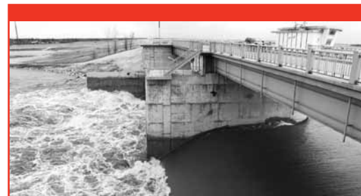
L'ouvrage régulateur d'entrée.
