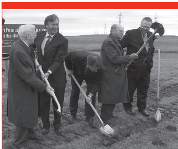
Des dignitaires participent à l'enlèvement du gazon à l'occasion de la cérémonie d'inauguration des travaux.
