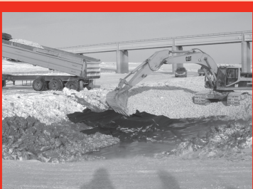
Mesures de protection contre l'érosion pour le chenal d'étiage
