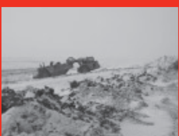
Excavation du canal de dérivation
