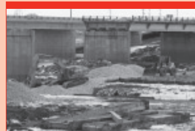
Achèvement de la démolition du carrefour direction sud du pont de la RPGC 59 Sud
