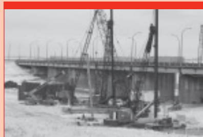
Enfoncement des pieux au site du pont de la route transcanadienne n° 1.
