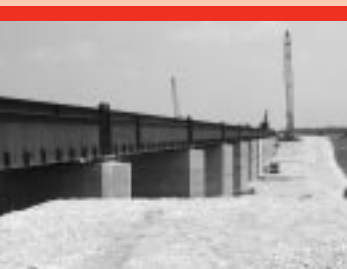
Le projet du pont ferroviaire CN Sprague fut terminé au printemps.
