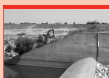
Un important projet d'agrandissement de l'ouvrage régulateur de sortie à Lockport a débuté cet été.
