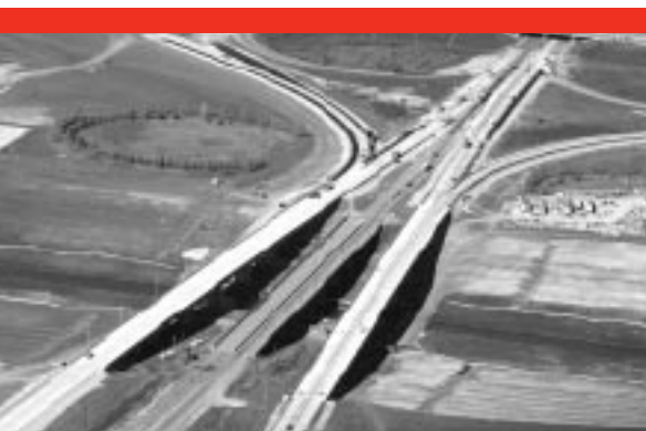
Le pont de la route transcanadienne à l'est de Winnipeg a été ouvert à la circulation en automne 2006.
