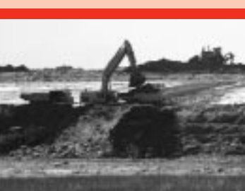
Les travaux d'excavation du chenal au cours de l'hiver 2007.
